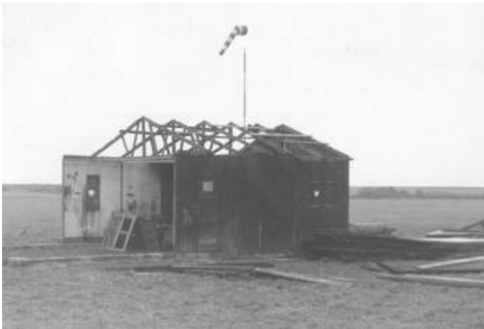
Die neue Werkstatt wird aufgestellt
